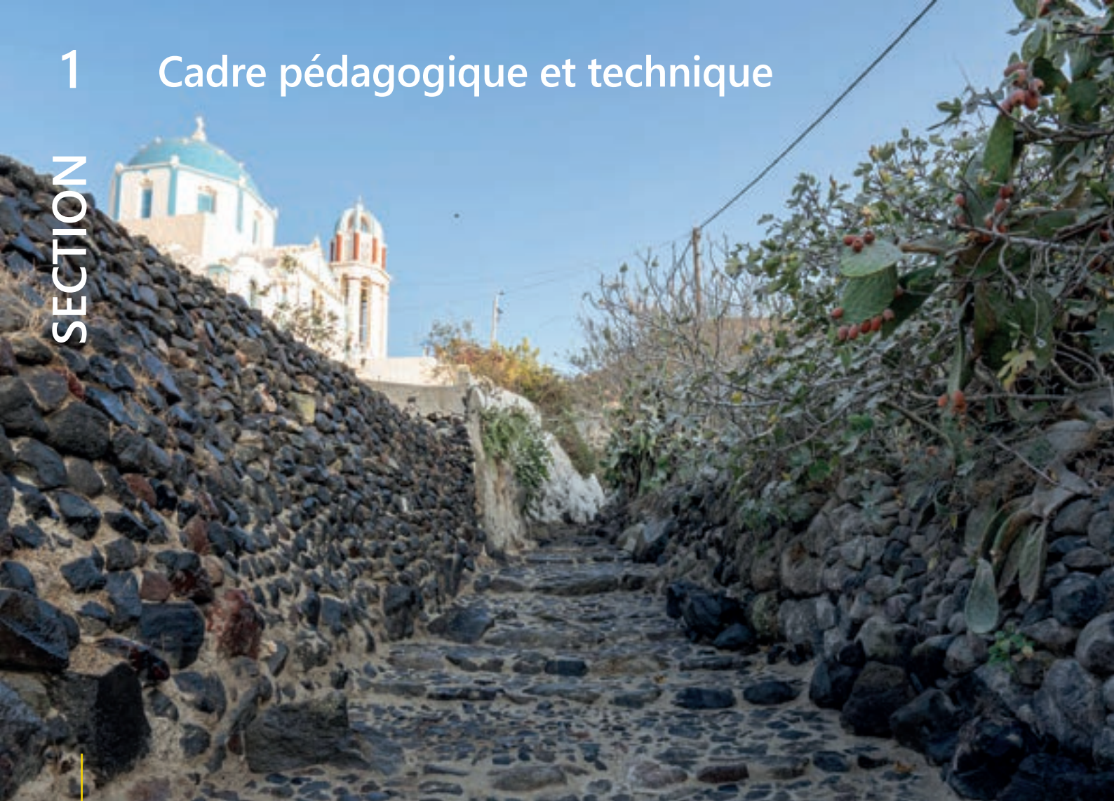
Chemin en pierres sèches et murs latéraux en pierres volcaniques dans les Cyclades, Grèce.
