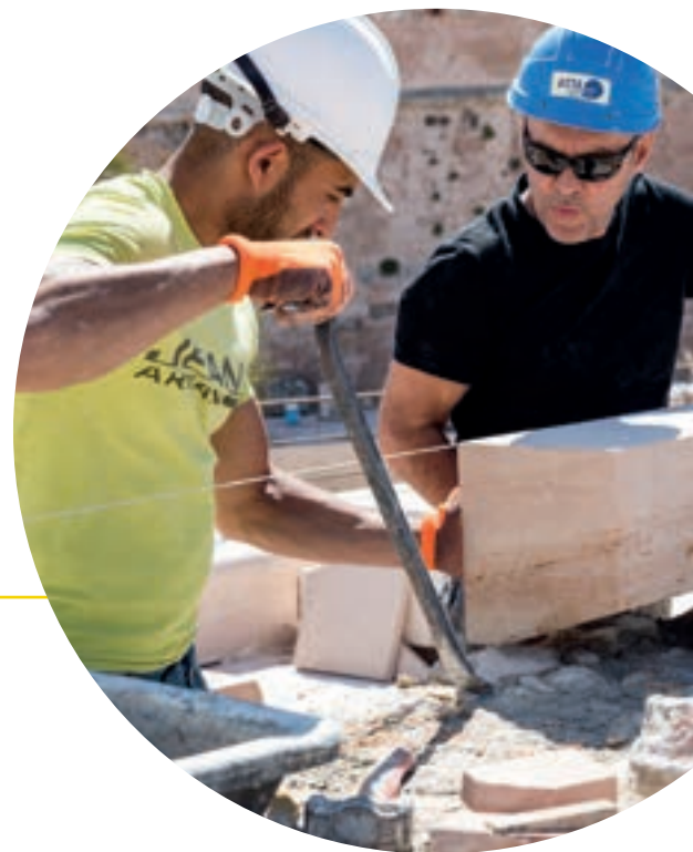
Apprenti et formateur posant des pierres sur le Fort St Nicolas - Marseille, France
